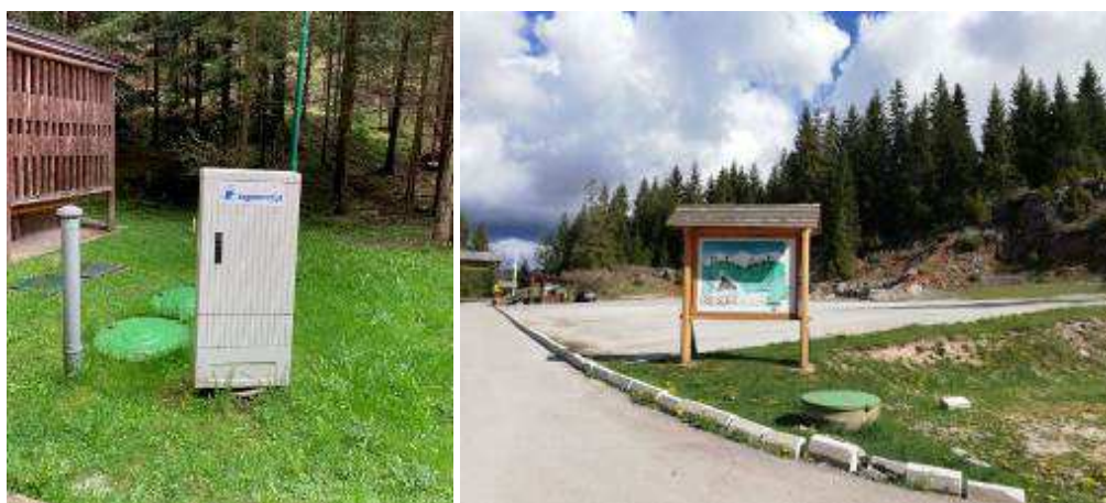
Slika 54: Lokacija bioprečištača (lijevo) i separatora ulja (desno)
